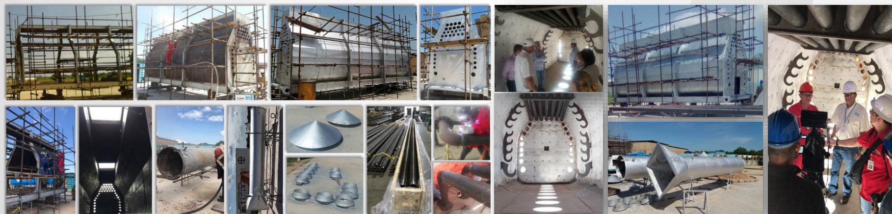
REPARACIÓN DE HORNO H-102. PETROPERIJA, 2017-2018.
