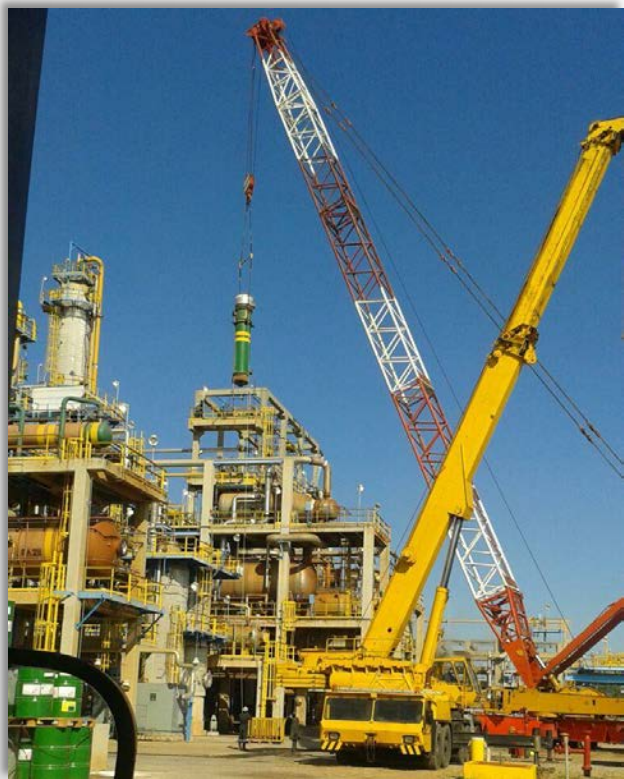
REEMPLAZO DE INTERCAMBIADOR E-225. POLINTER, 2016.
