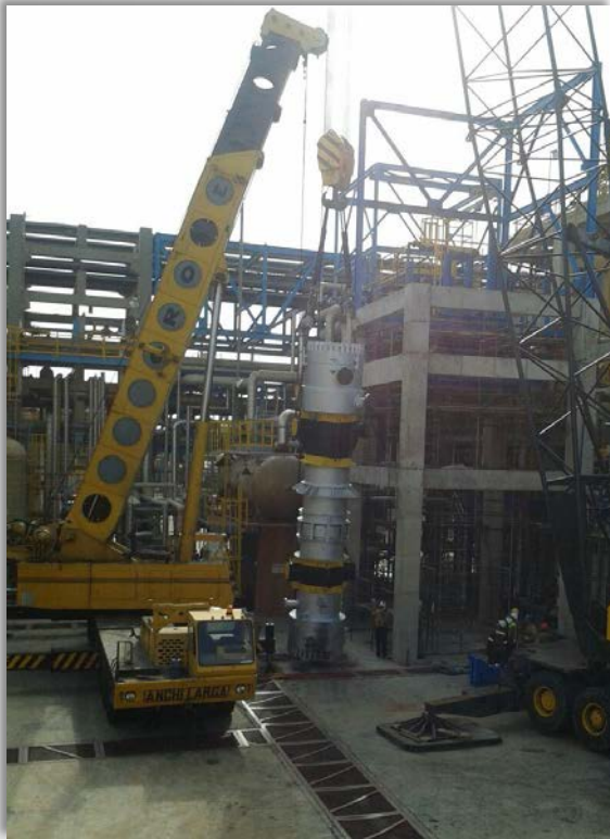
INSTALACIÓN DE PRECALENTADOR EA-105S. POLINTER, 2016.
